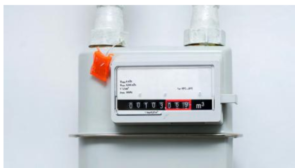
Maintenance de compteur à gaz
