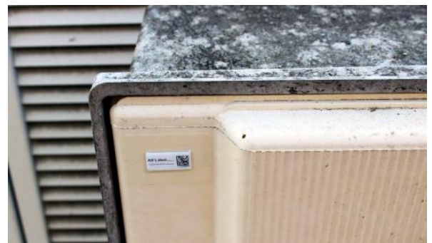
Inspection de postes électriques
