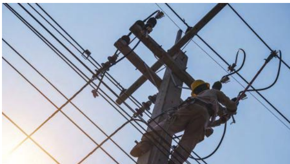
Identification de transformateurs
