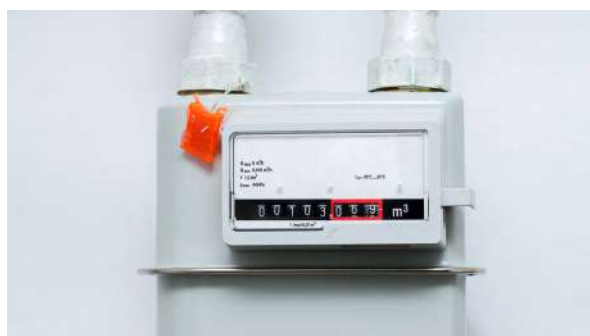
Maintenance de compteur à gaz
