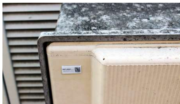
Inspection de postes électriques
