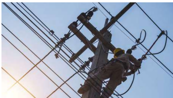
Identification de transformateurs
